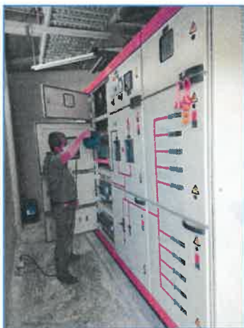
ภาพถ่ายที่ 2.2-25 การตรวจสอบระบบไฟฟ้าส่วนกลางและการตรวจสอบระบบควบคุมไฟฟ้า MDB
