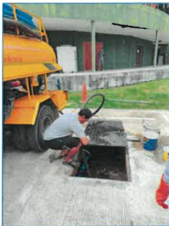
ภาพถ่ายที่ 2.2-17 การดูตกตะกอนจากระบบบำบัดน้ำเสีย
