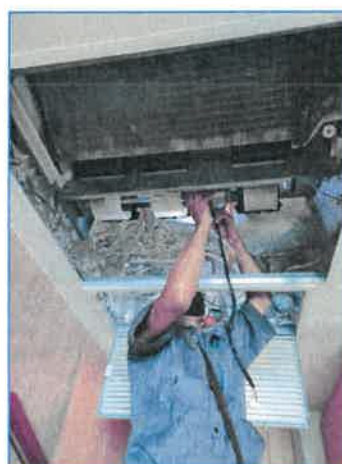
ภาพถ่ายที่ 2.2-31 การทำความสะอาดระบบปรับอากาศและระบบระบายอากาศ
