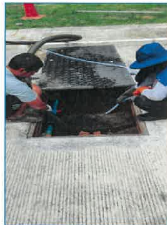
ภาพถ่ายที่ 2.2-17 การดูตกตะกอนจากระบบบำบัดน้ำเสีย
