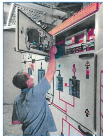
ภาพถ่ายที่ 2.2-25 การตรวจสอบระบบไฟฟ้าส่วนกลางและการตรวจสอบระบบควบคุมไฟฟ้า MDB
